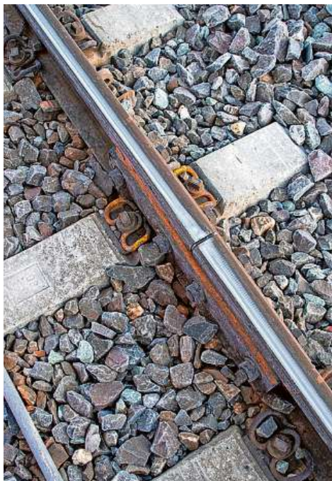
Ist bei den Isolationsstössen alles in Ordnung?
